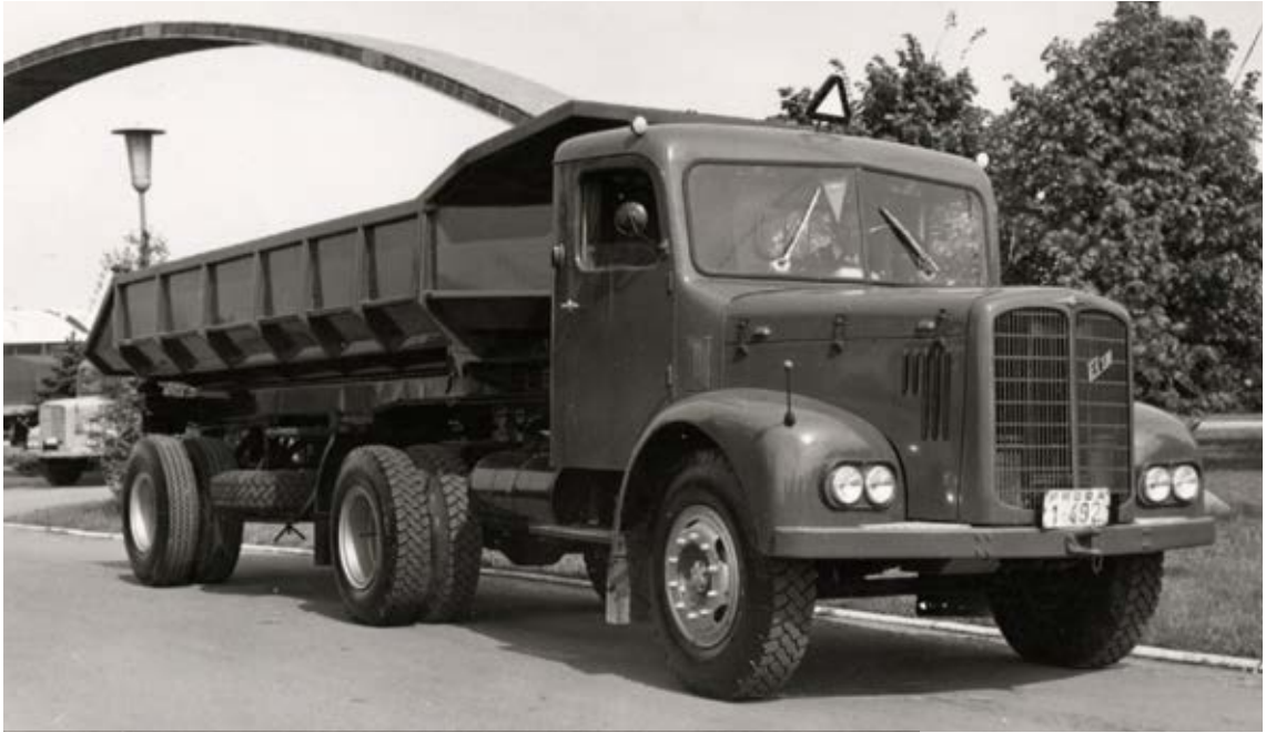
Ko so predstavili FAP 13, so proizvodnjo 4-valjnega modela opustili – na tovarniški fotografiji je model 13 TK (tegljač, kiper – vlačilec prekucnik)
